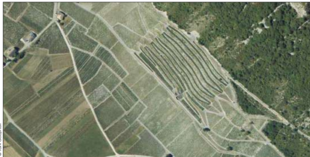
Détail de la vue aérienne actuelle du coteau de Tormery (Chignin, Savoie) avec les terrassements des années 1980 et juste au-dessus la trace des anciennes parcelles de vignes reboisées.
